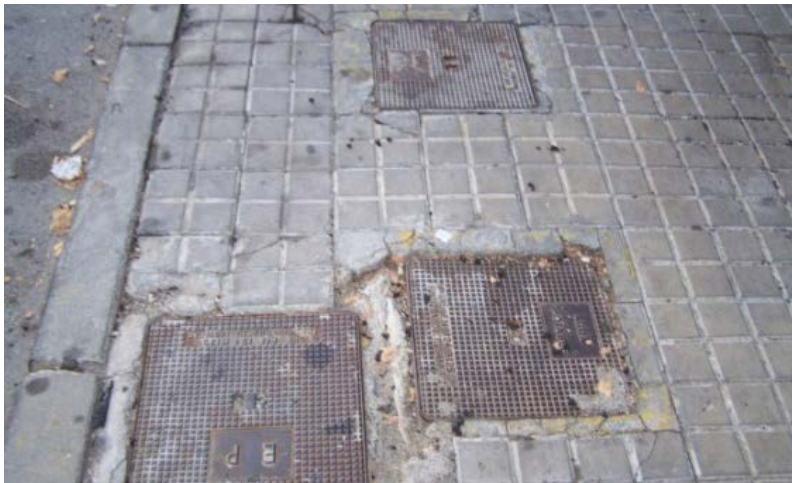
Fig. 20 i 21. Estat de la preexistència: calçades i voreres Imatge extreta de la presentació de Serra, R., jornada REfabriCAT.2017, LITA-UPC
